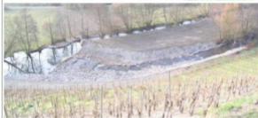
Sohlschleife direkt nach der Fertigstellung
