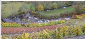
Sohlschleife 5 Jahre nach dem Bau
