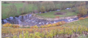
Sohlschleife 1 Jahr nach dem Bau
