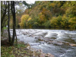
Sohlengleite ca. 1 Jahr nach Inbetriebnahme
