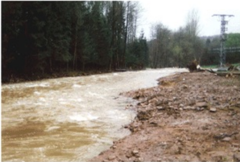
Hochwasser (Feb. '02) direkt nach dem Bau führte zur Zerstörung der Buhnen.
