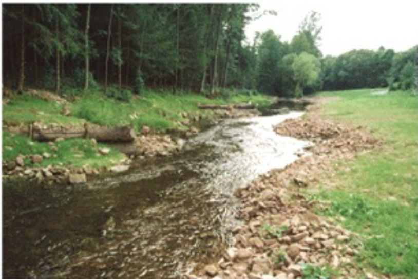
"Neue" Buhnen (Juli '02): Entwicklung eines pendelnden Stromstriches, Seitenerosion gegenüber.
