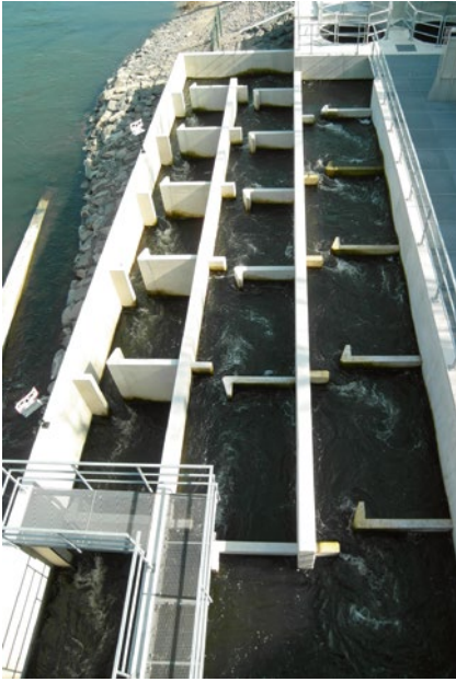
Bild 4: Unterschiedliche Strömungsbilder im Schlitzpass Koblenz: rechte Rinne: Zwischenzustand; mittlere und linke Rinne: eher durchgehende Strömung von Schlitz zu Schlitz (Quelle: Gebler)
