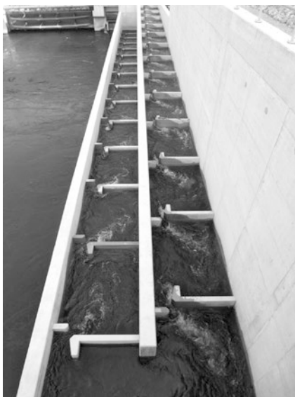
Bild 1: Schlitzpass Kraftwerk Rheinfelden am Hochrhein (Quelle: Gebler)
